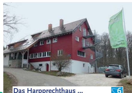
Das Harpprechthaus ... und die Gedächtnishütte auf der Schwäbischen Alb wurden grundlegend saniert und umgebaut. Abschließend gab es ein Fest.
