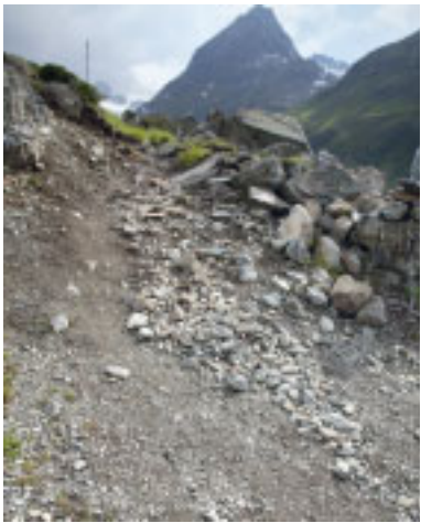
Weg zum Rußkof vor der Sanierung
