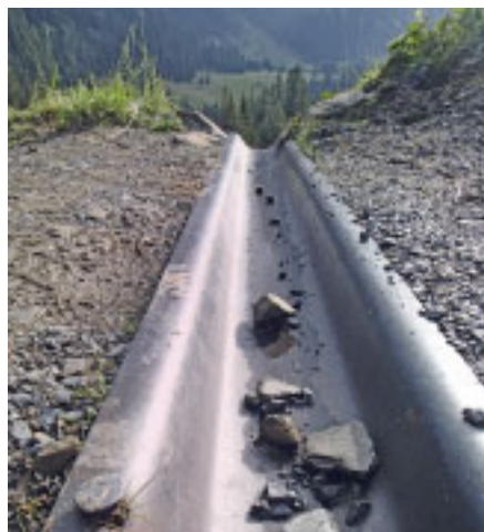
Frisch sanierte Entwässerungsrinne
